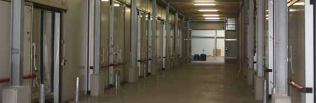
Blick in das gerade in Betrieb genommene CA-Lager für Heidelbeeren Fotos (3): Kühlwetter
